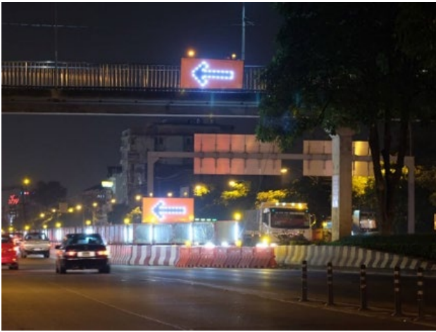
การติดตั้งไฟส่องสว่างและป้ายเตือน ตามแนวก่อสร้างเพื่อป้องกันอุบัติเหตุ
