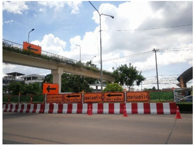
การติดตั้งไฟส่องสว่างและป้ายเตือน ตามแนวก่อสร้างเพื่อป้องกันอุบัติเหตุ
